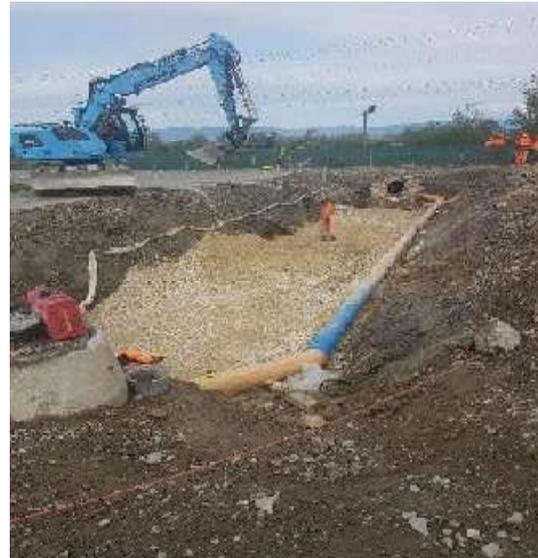
Mise en place de l'aqueduc (2 éléments bétonnés hors fouille)
