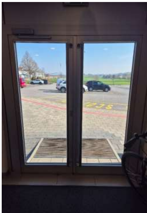
Porte d'entrée principale
